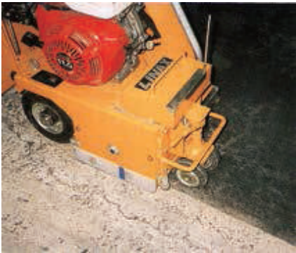
■油の浸透した コンクリート面のハツリ
