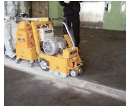
■エポキシ樹脂モルタル (7ミリ)の除去
